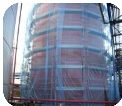
欧洲炼油厂储罐经高压水冲洗后涂覆2层 Resichem 555 Resinox
